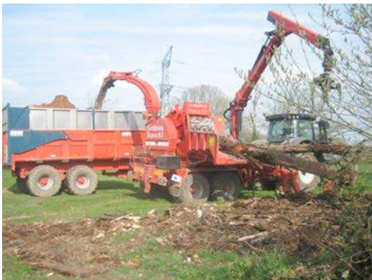
Le chantier de broyage
